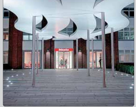
▲ Haupteingang in Gütersloh
